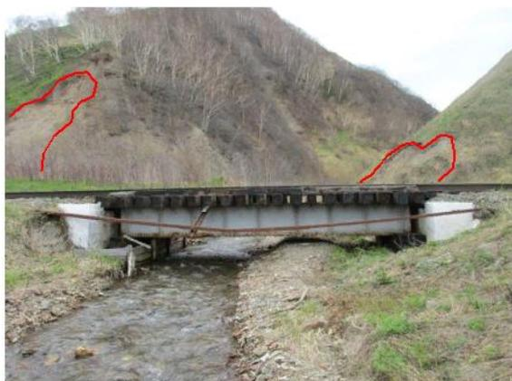
*Рис. 2. Общий вид склонов в районе моста (красным цветом показаны участки развития оползневых процессов)*
