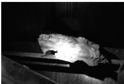
Рис.5. Соляное отложение, деформировавшее ротор и вызвавшее аварийную остановку аппарата
