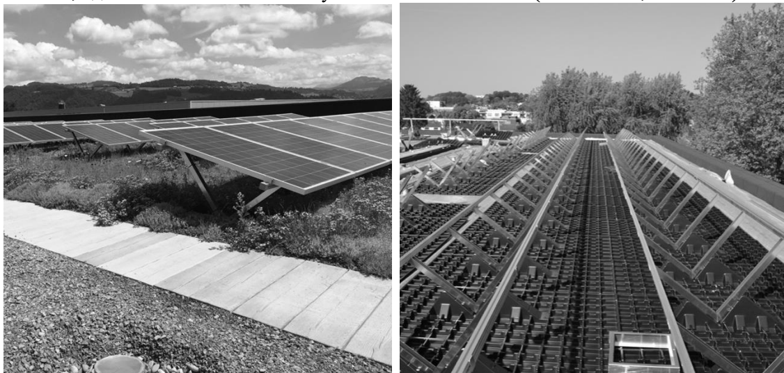
Рисунок 1. Комбинированная система кровельного озеленения и солнечных панелей. Офисное здание, Ютендорф, Швейцария (источник: optigruen.com)
